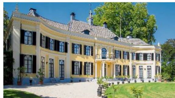
Gelb und Weiß stehen möglicherweise nicht für die Originalfarbe(n) des Gebäudes. Die ließ(en) sich aber nicht mehr ermitteln. FOTOS: FRITHJOF NOWAKEWITZ
